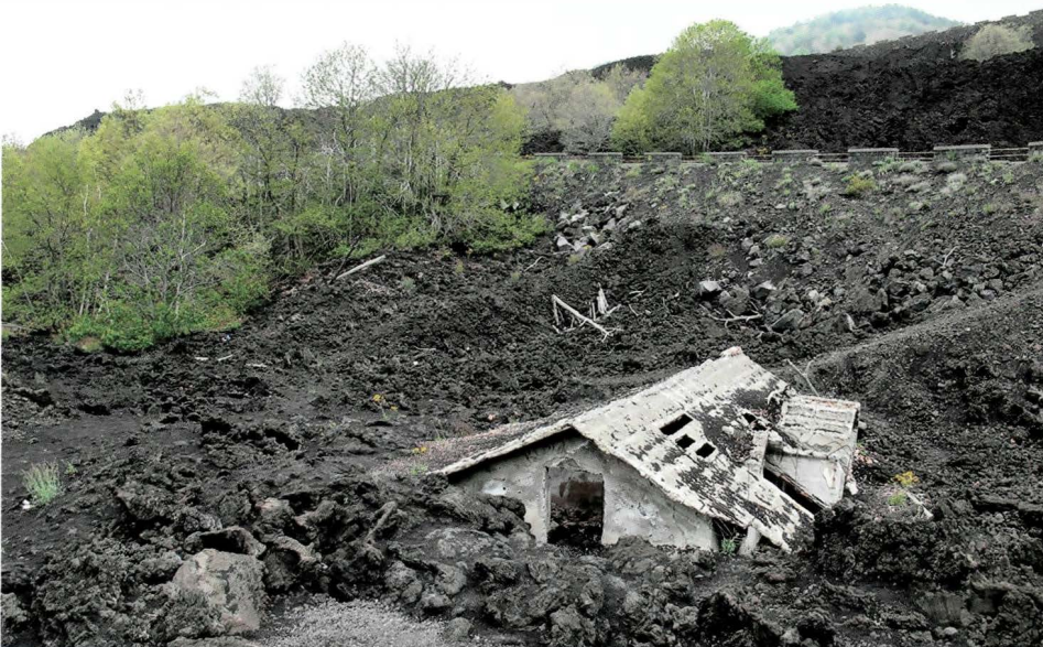
M3 Zerstörtes Haus am Ätna
